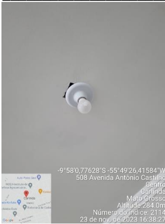
FOTO 7: Forro de gesso com recorte aparente.
